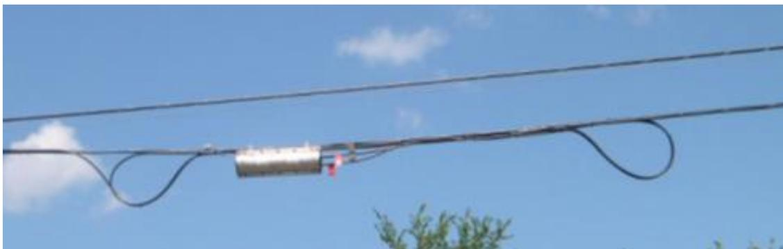
**Figure 3F - MOU sur la fibre optique (entrée à gauche)**
